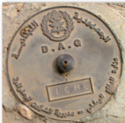
Głowica punktu geodezyjnego
